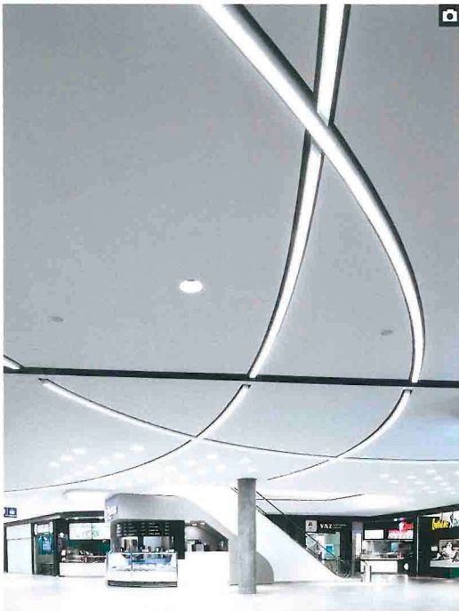
Decken ohne störende Technik • Ceilings without technical installations
